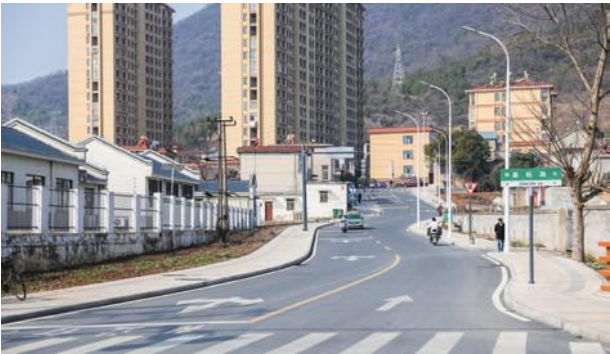
维西路拓宽改造工程
